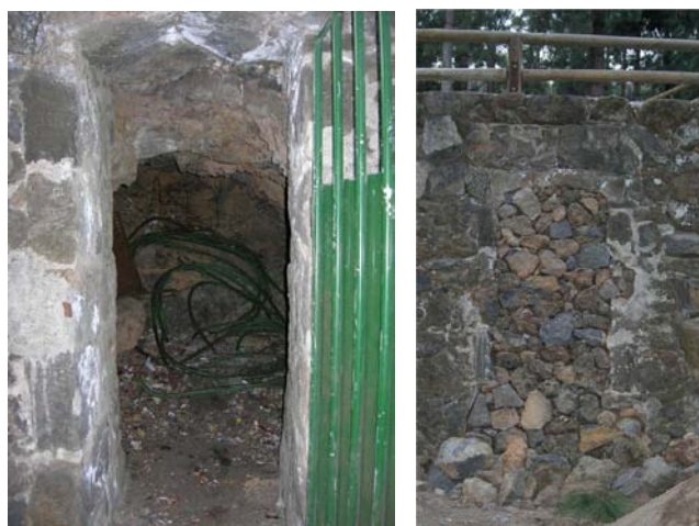
El cierre de un almacén de basura, que no reunía las condiciones adecuadas, fue una medida efectiva para controlar las ratas de esta localidad.
